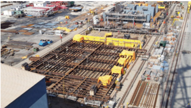
Strutture del nuovo Living Quarter
