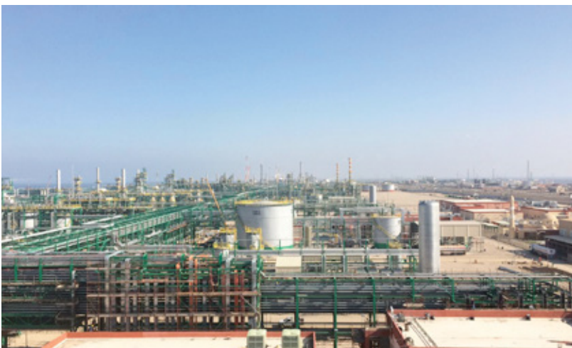
Impianto OnShore di Zohr
